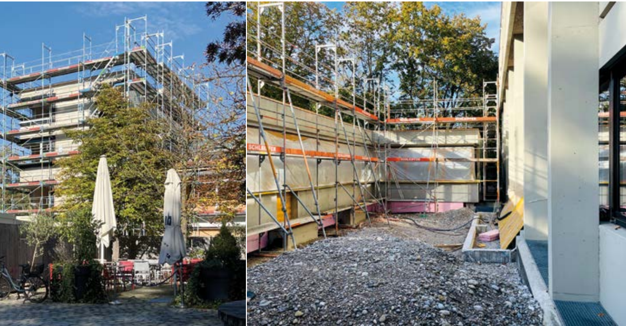
Anbau an das Rathaus auf der Westseite
