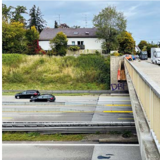
Blick von der Brücke in der Maria-Eich-Straße auf die Autobahn
