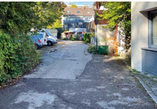
Der südliche Abschnitt der Straße An der Würmleiten wird ab dem Frühjahr 2025 saniert
