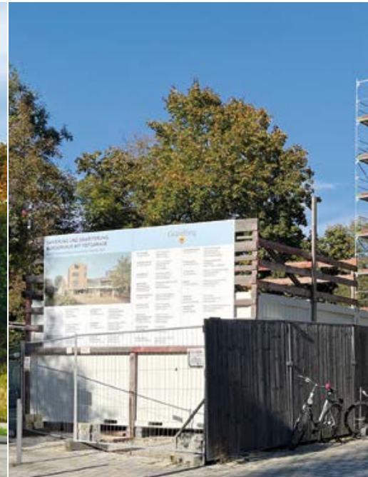
Das Bürgerhaus mit neuem Turm
