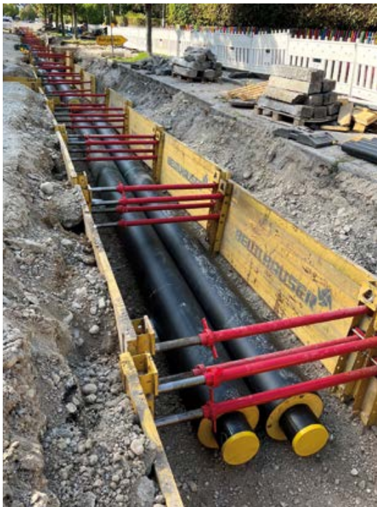
Rohrleitungsbau für das Fernwärmenetz in der Bahnhofstraße
