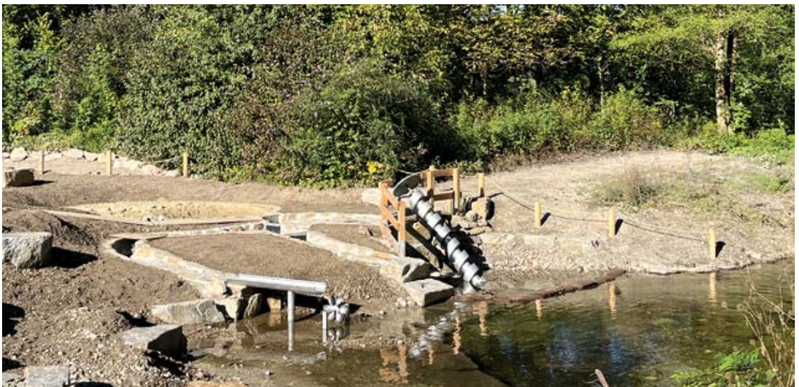
Der Wasserspielplatz kurz vor der Fertigstellung
