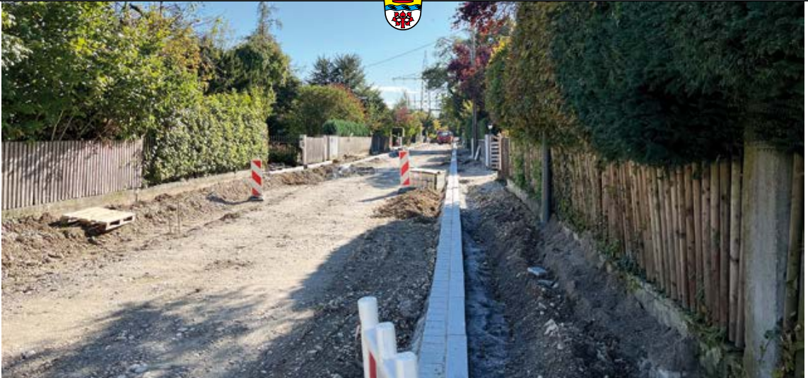
Sanierung der Schiltbergerstraße
