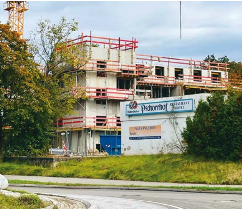
Blick vom Kreisel auf den Rohbau des Rudolf und Maria Gunst-Hauses
