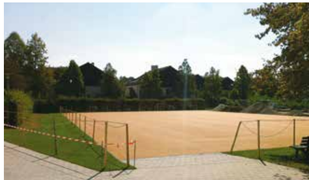
Allwetterplatz an der Schulstraße kurz nach der Sanierung
