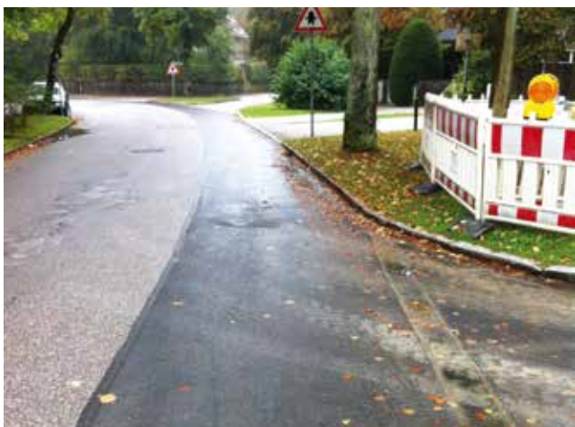
Abgeschlossene Arbeiten an der Unterbrunner Straße
