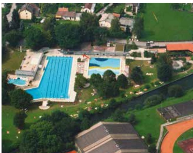
Luftbild 1991: Erneuerungen der Becken, neues Kleinkinder-Planschbecken, Whirlpool statt Sitzgelegenheiten am Sportbecken, auf dem Dach neue Räume für die Bademeister. (Bavaria Luftbild Verlags GmbH, 1991, 826 A2 / Gemeindearchiv Gauting)
